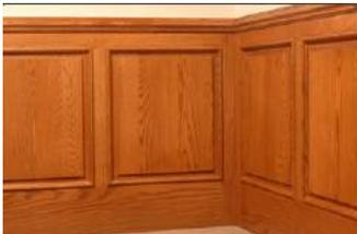
**RIEL (RAIL):** Las piezas transversales o horizontales de un conjunto de montantes y rieles o las piezas transversales del conjunto central de una puerta a ras o panel de revestimiento de madera.
